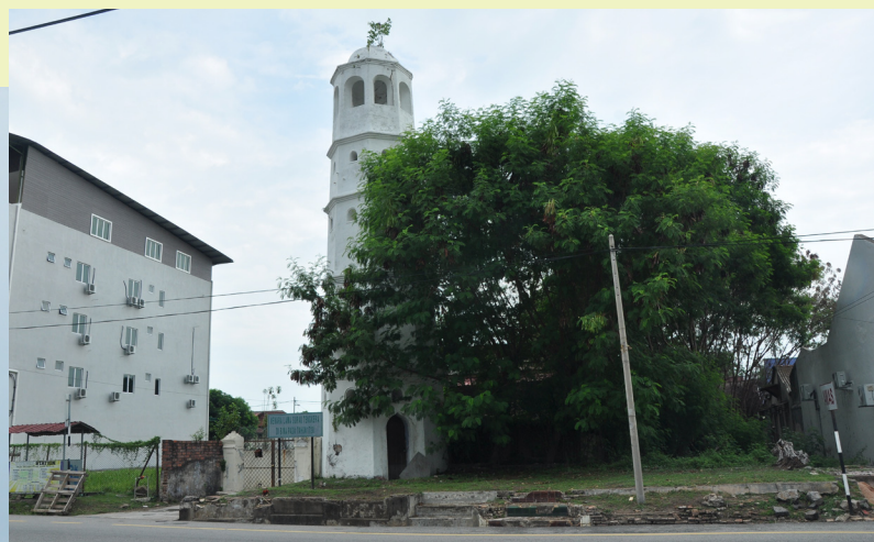
Tapak Mahkamah Kadi di Tengkerah yang kini bangunannya telah pun diruntuhkan
